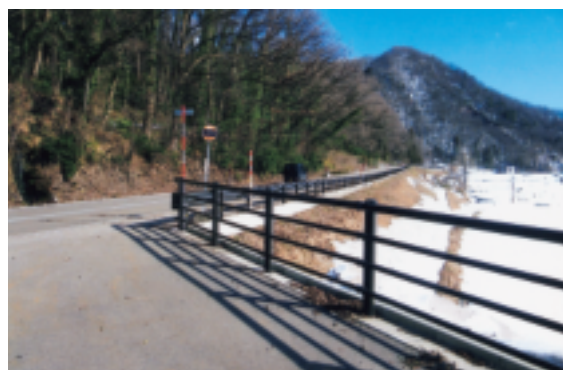
県道石引～小原線拡幅工事
