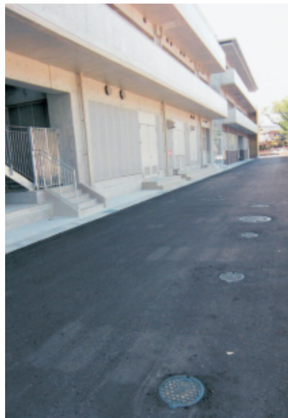
新設された「マンホールトイレ」。左側が防災倉庫
