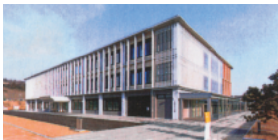
太陽が丘3号棟竣工（平成29年3月22日）
