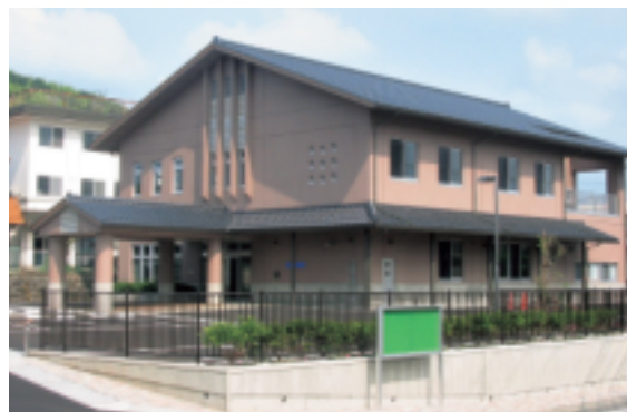
完成した犀川地域総合センター
