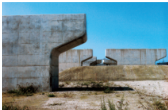
海側幹線「浅野川橋梁（仮称）」の橋脚工事
