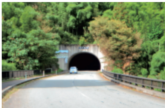
内川第1号の山川トンネル
