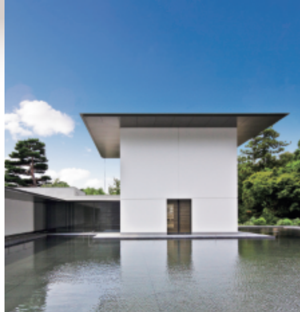
鈴木大拙館 平成23年10月開館〈本多町3丁目〉(金沢市提供)
