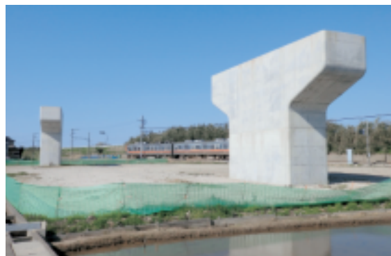
海側幹線延長工事
