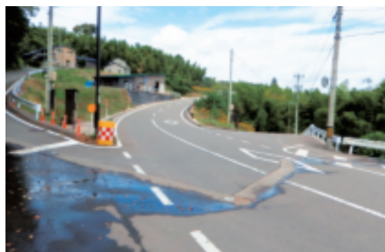
深い谷を盛土し地滑り対策もされた道路
