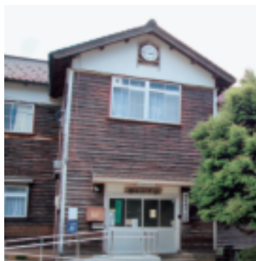
旧朝日小学校校舎の旭日公民館
