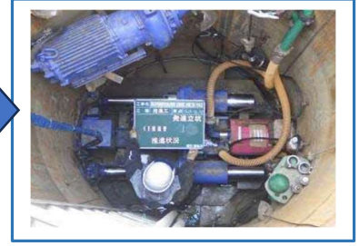
○推進管・総合管敷設
