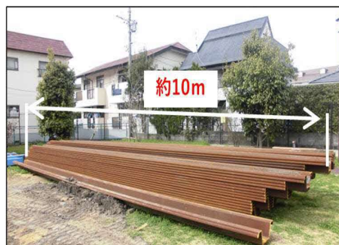
【写真 遮水鋼矢板】
