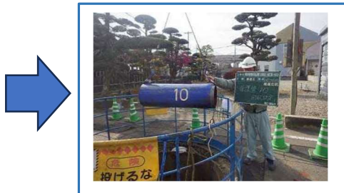
○推進管・複合管回収
